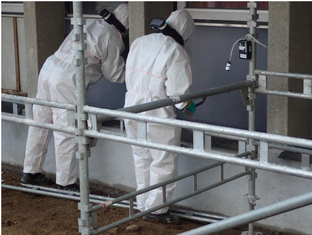
Figur 2. Udendørs målinger, personbårne og near-field. Pumperne er inde under dragten, så de ikke forurenes under arbejdet.
