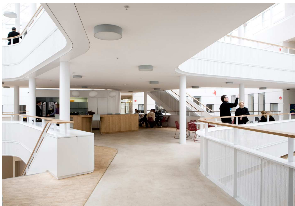
Figur 42. Interiør fra Tryg Vesta med integrerede akustiske løsninger i lofter (akustisk puds) i balkonværn (perf. metalplader) og i vægge bag skranke.
