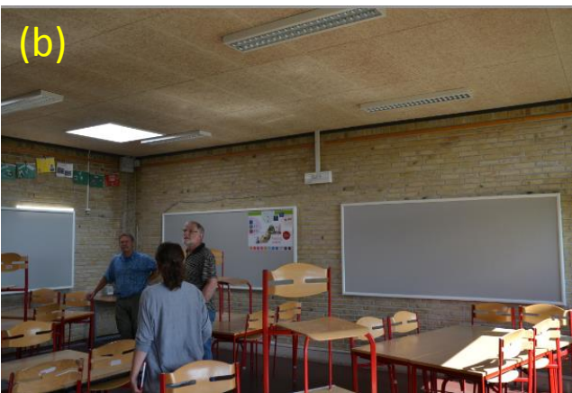
Figur 1. Strandskolen: Typisk klasselokale (a) før og (b) efter akustisk renovering. Foto: PKL
